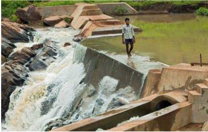
LAYA-Wasserkraftprojekt in Pathakota.
