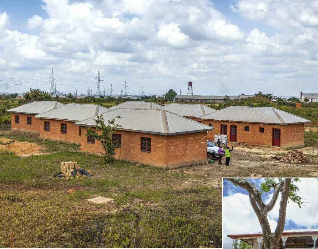
Kongo: Das Ausbildungszentrum wurde in Lehmbauweise (gepresste Lehmziegel) errichtet. Das Material konnte direkt vor Ort gewonnen werden.
