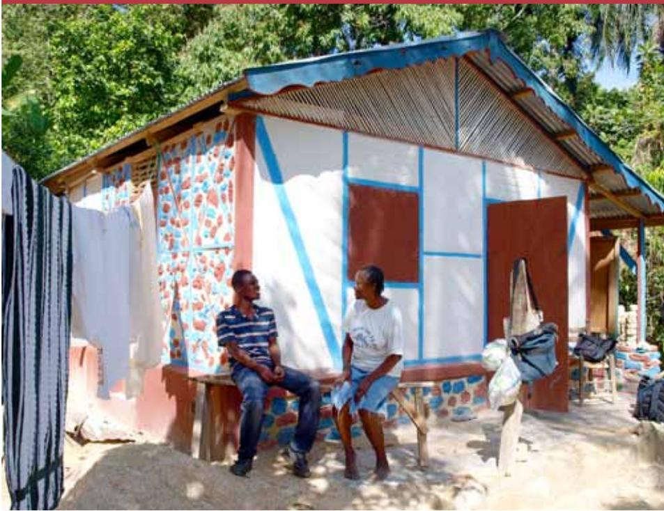
In Selbsthilfe gebautes Wohnhaus in Carrefour, Haiti. Es ist in erdbebensicherer, traditioneller Bauweise aus Holz und Naturstein errichtet.
